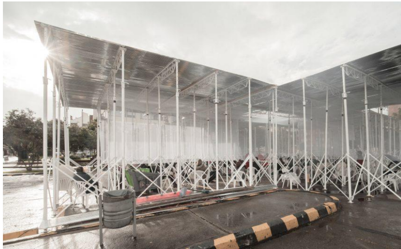
La iglesia temporal está construida con sistemas y materiales tradicionales.
