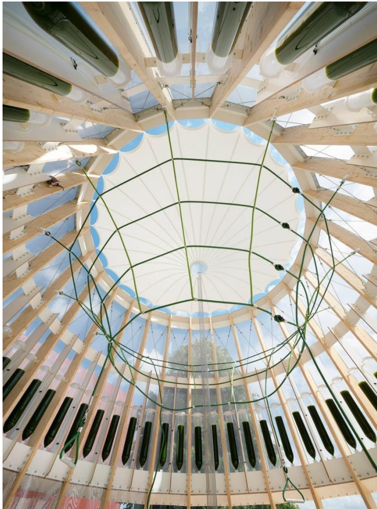
Las estructuras cónicas invertida de las membranas del techo contribuyen a la circulación del aire.
