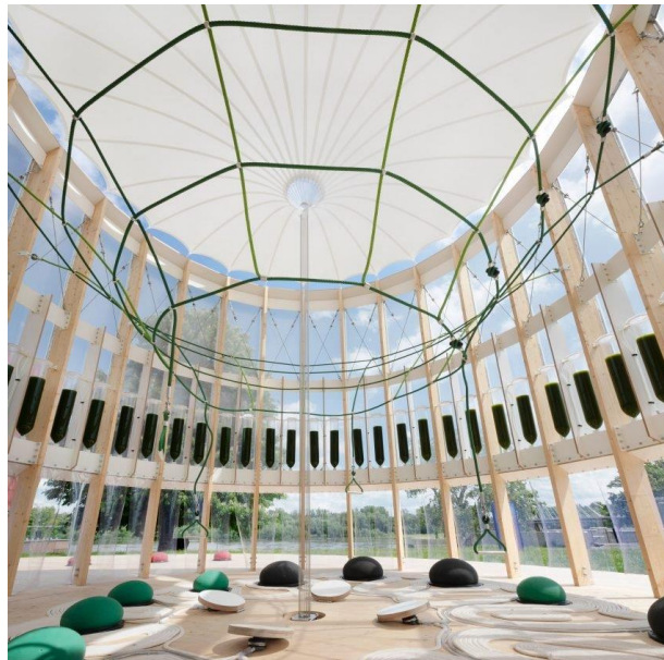
La estructura de madera contiene un anillo de biorreactores rellenos de algas.
